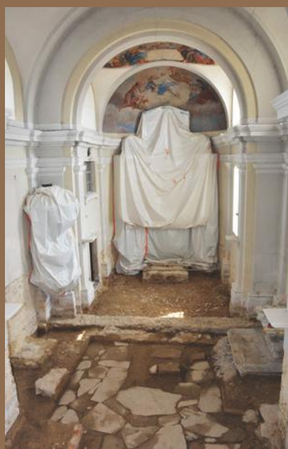
Blick von der Chorempore auf die Grabungsstelle im Kirchenraum.
